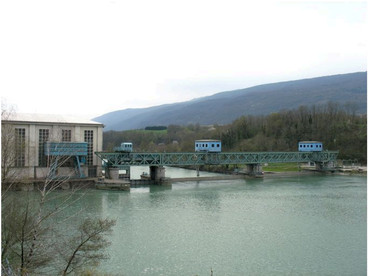
Vue de l'usine-barrage, face amont (nord), depuis la rive gauche
