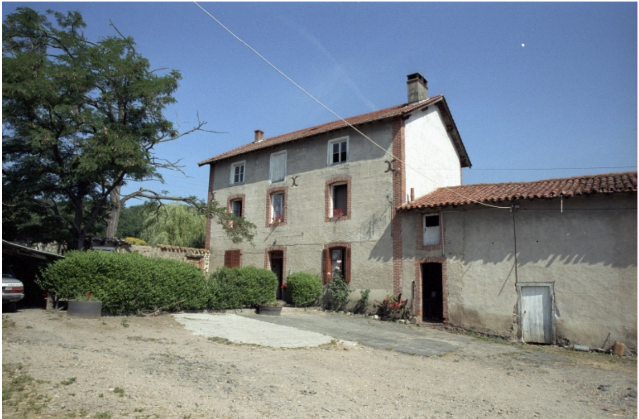
Vue d'ensemble du logis et de la grange-étable attenante.
