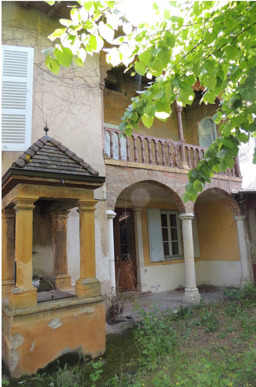
Façade sur jardin, partie sud-ouest : galerie à arcades.
