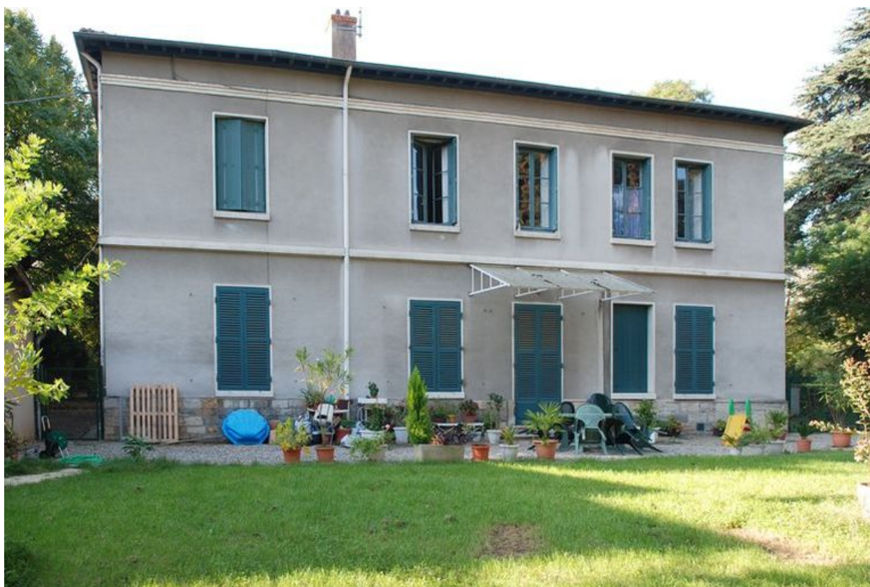
Bâtiment 512, façade postérieure (nord)
