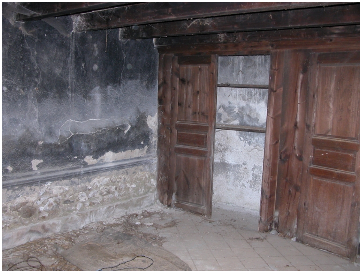
Vue intérieure de la chambre ou salle au rez-de-chaussée.
