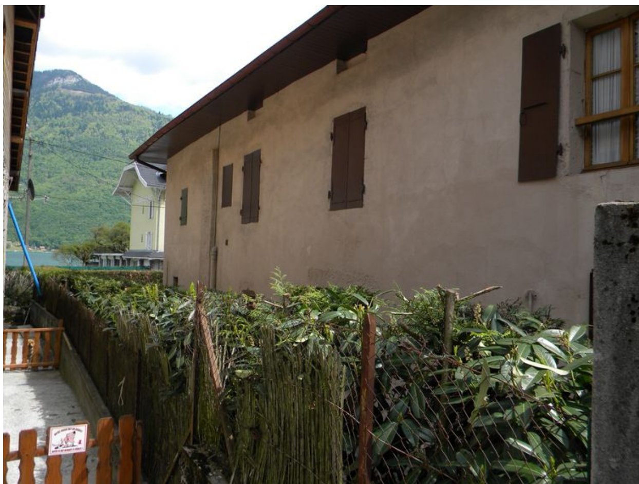
Vue de la façade nord.
