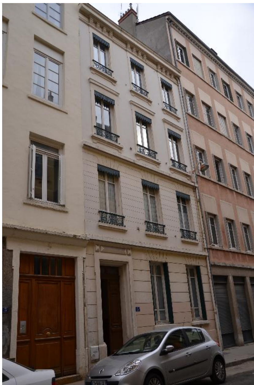
Vue d'ensemble façade sud
