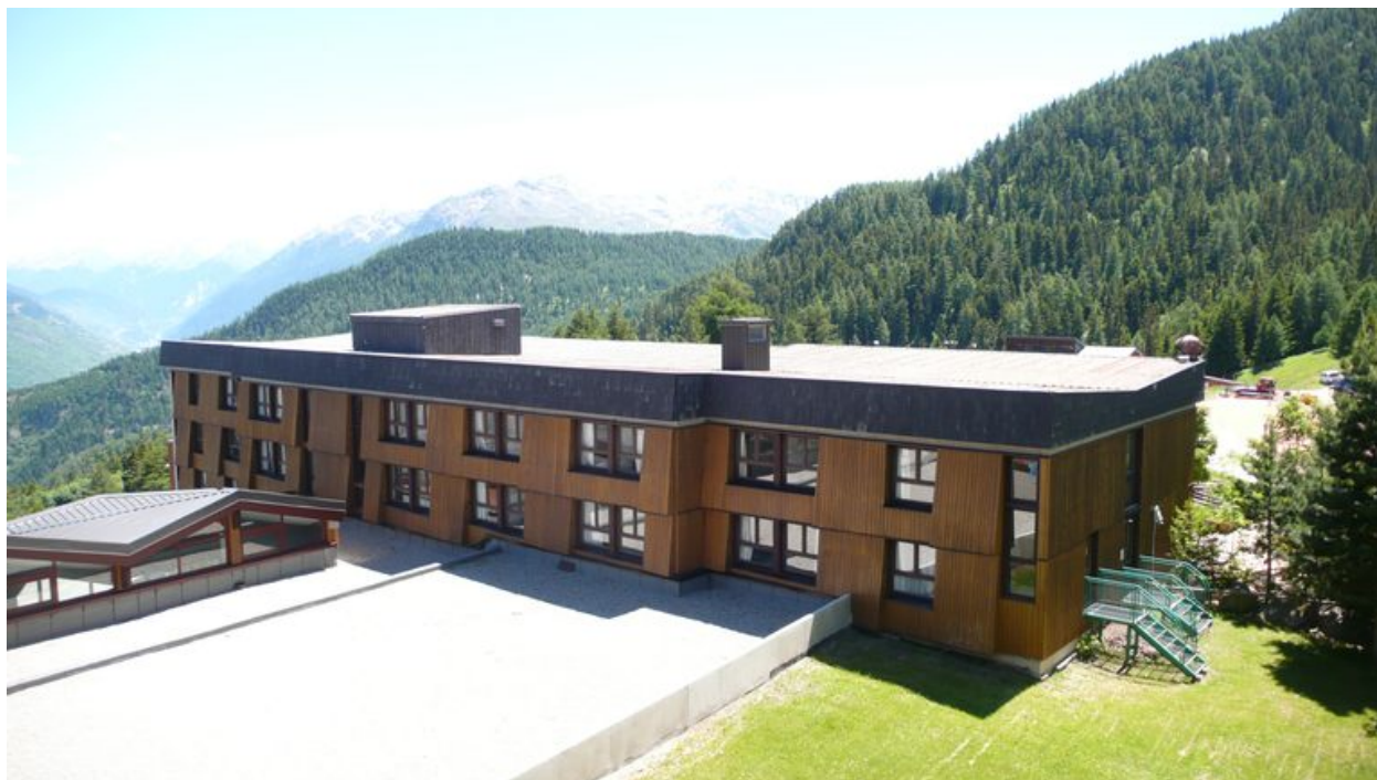
Façade nord, le toit du bâtiment B au 1er plan
