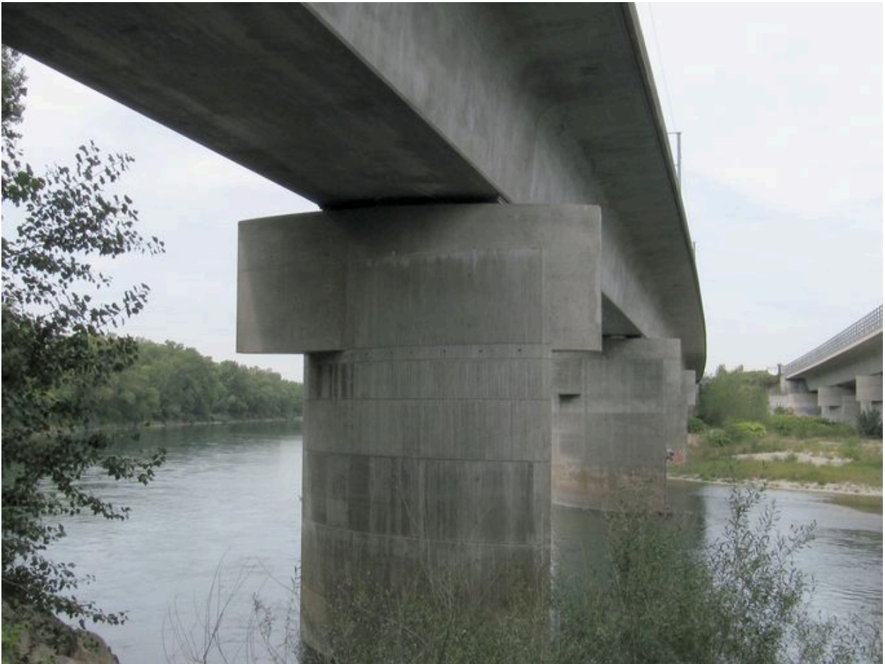
Vue générale de la partie du pont sur le canal de Miribel, face amont (depuis la rive gauche)
