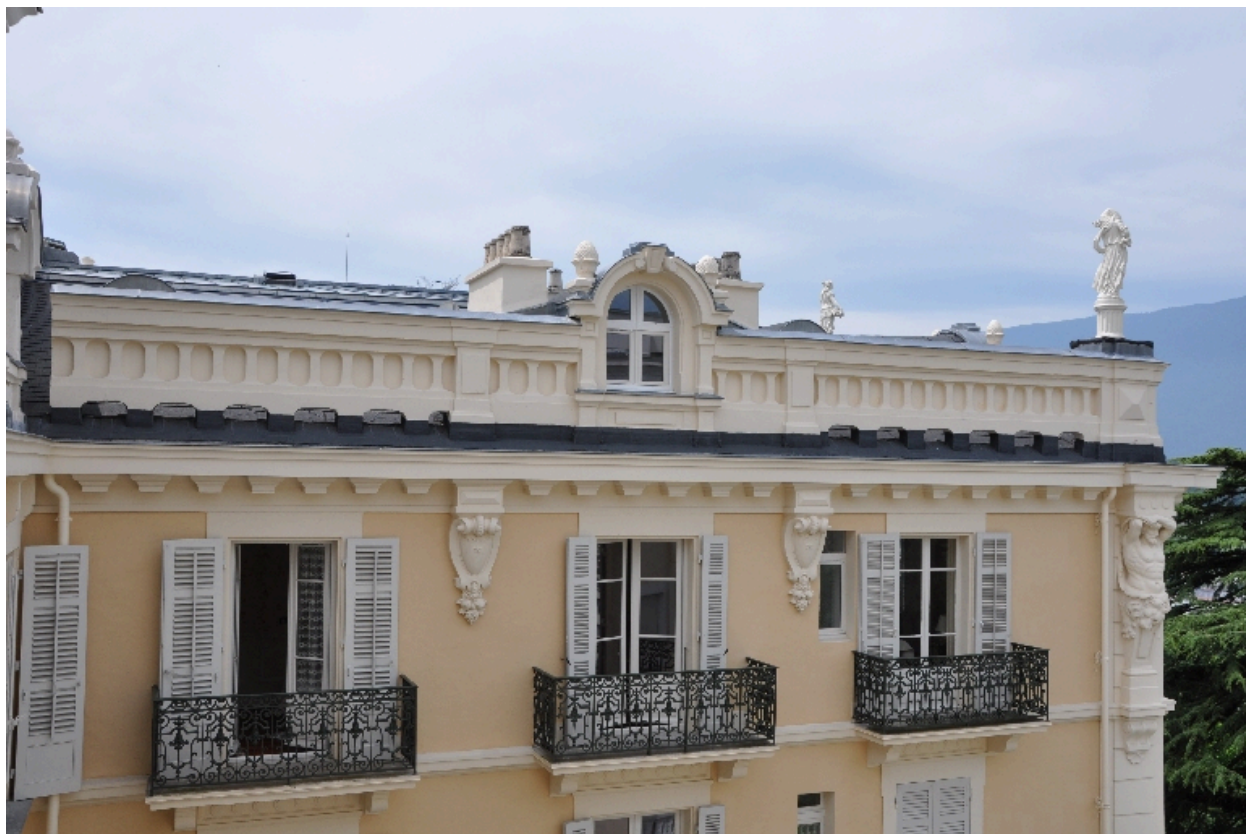
Détail du haut de la façade nord
