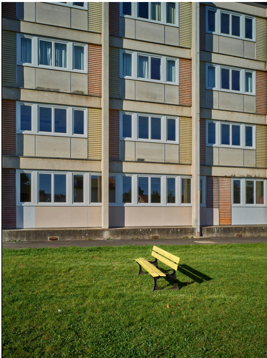
Bâtiment D1, façade est, détail.
