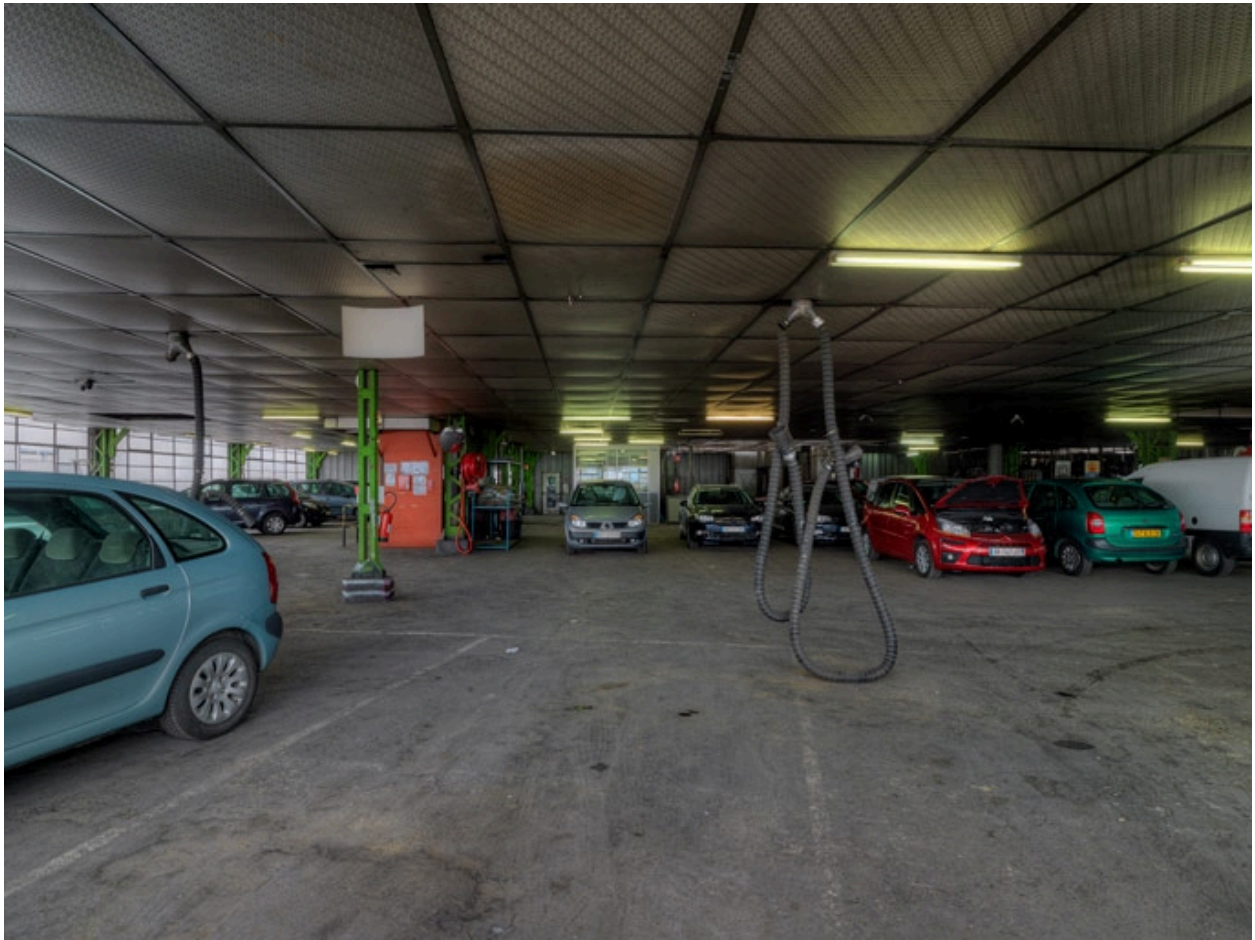
Vue d'ensemble du 4e étage
