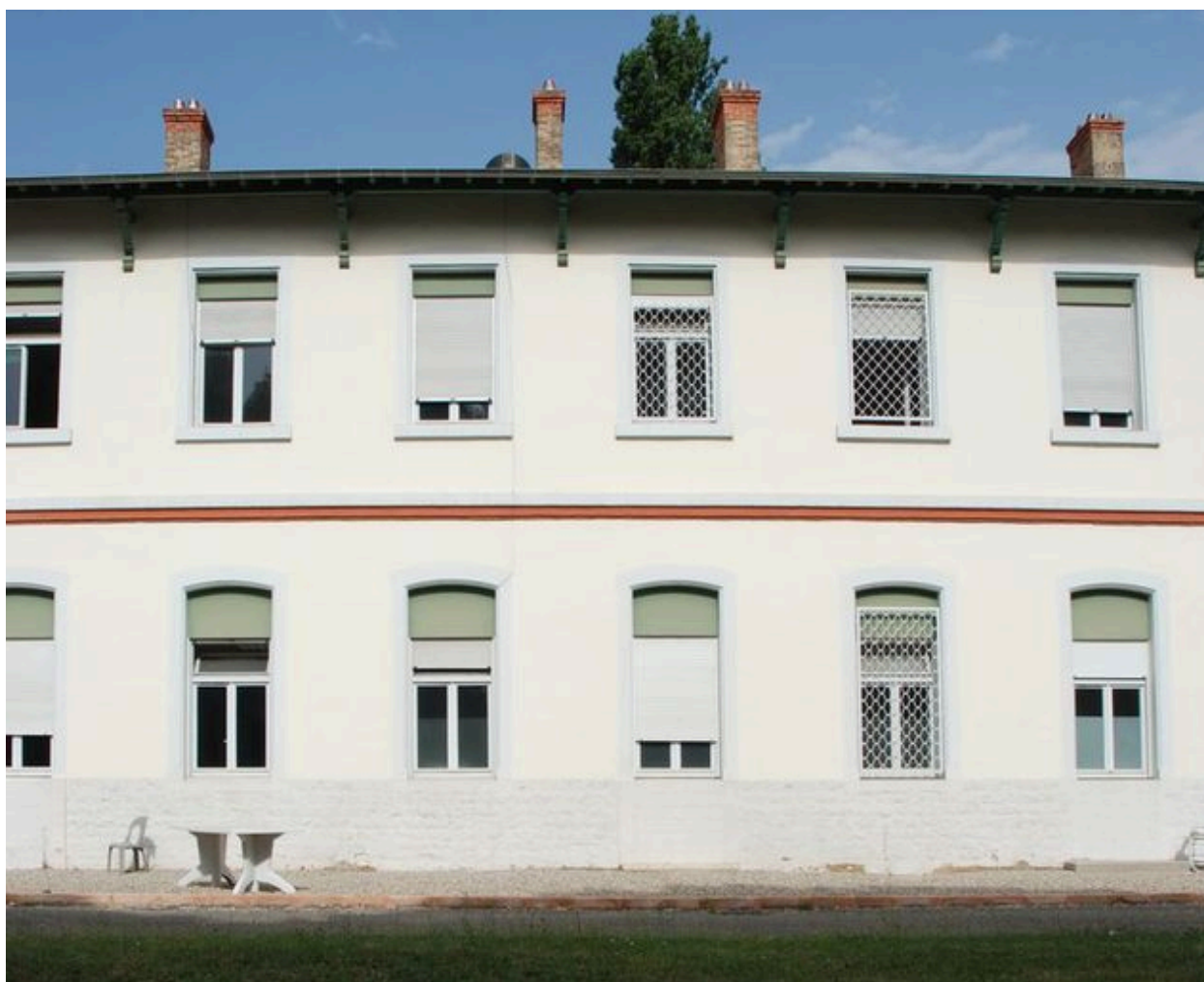
Façade postérieure (est), détail du corps principal
