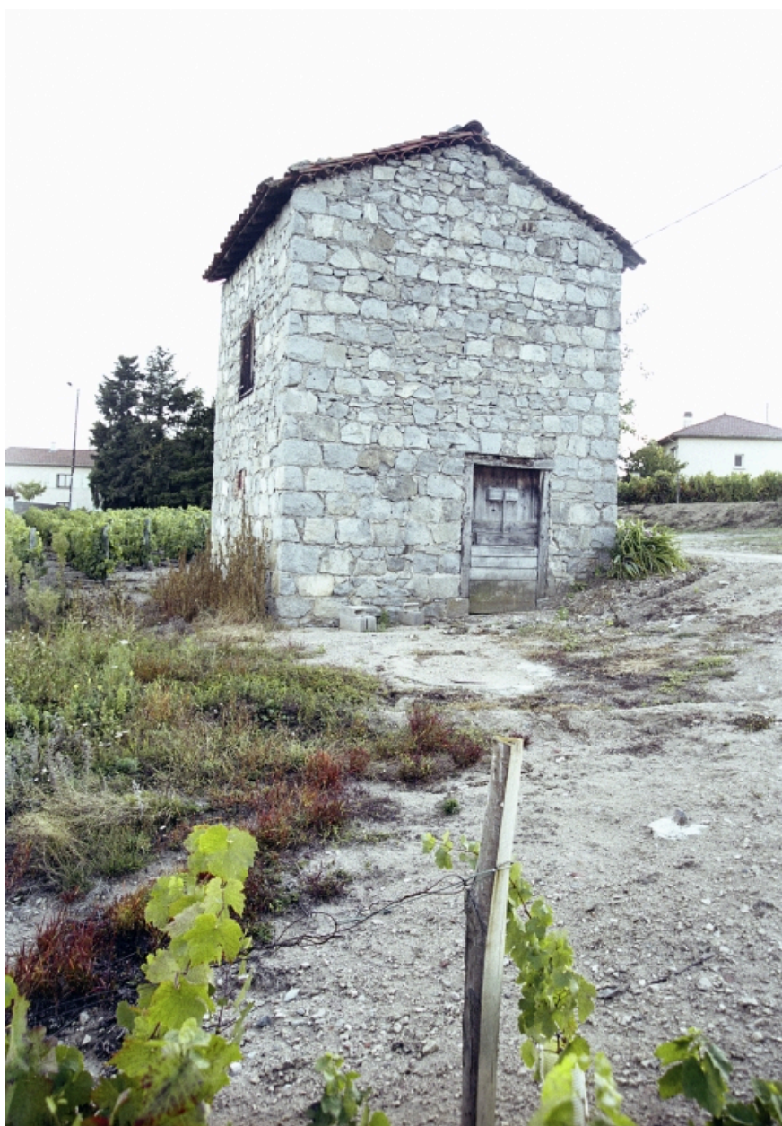
Boën, La Garde-Ouest (1986 AI 45, 46). Loge de type E2a1. Vue d'ensemble.
