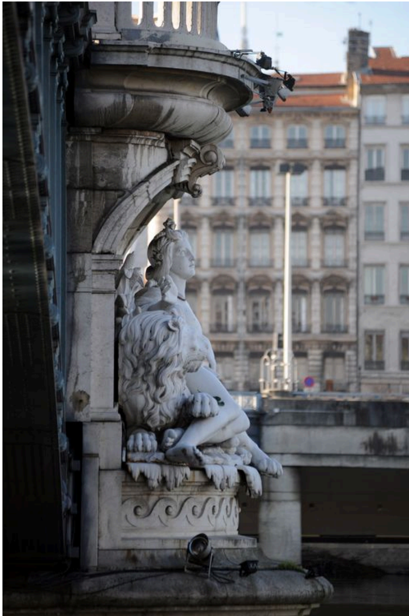
Pile avec la statue de la Saône, face amont, vue générale : de côté (depuis la rive gauche)
