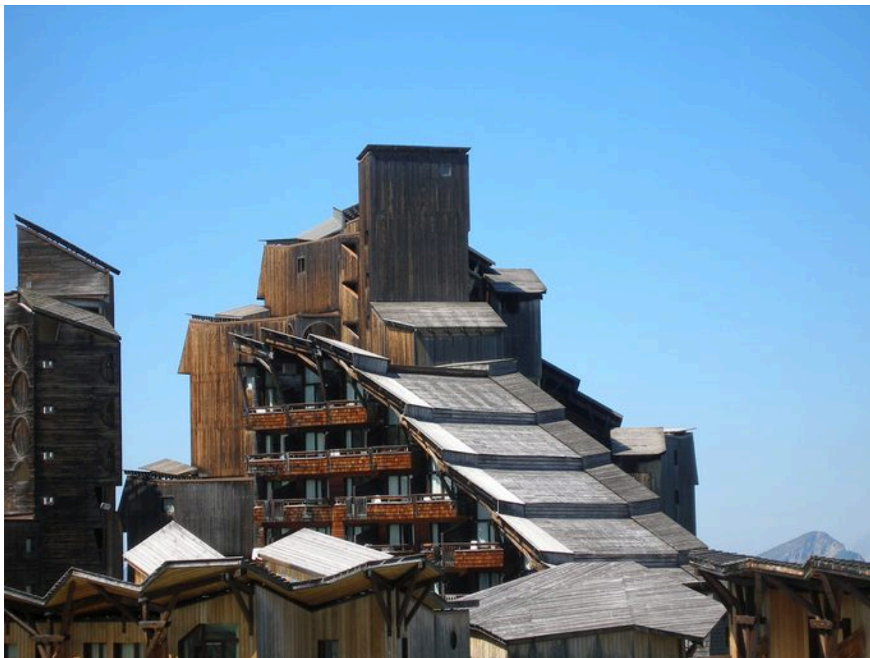
Vue d'ensemble des toits depuis le nord-est
