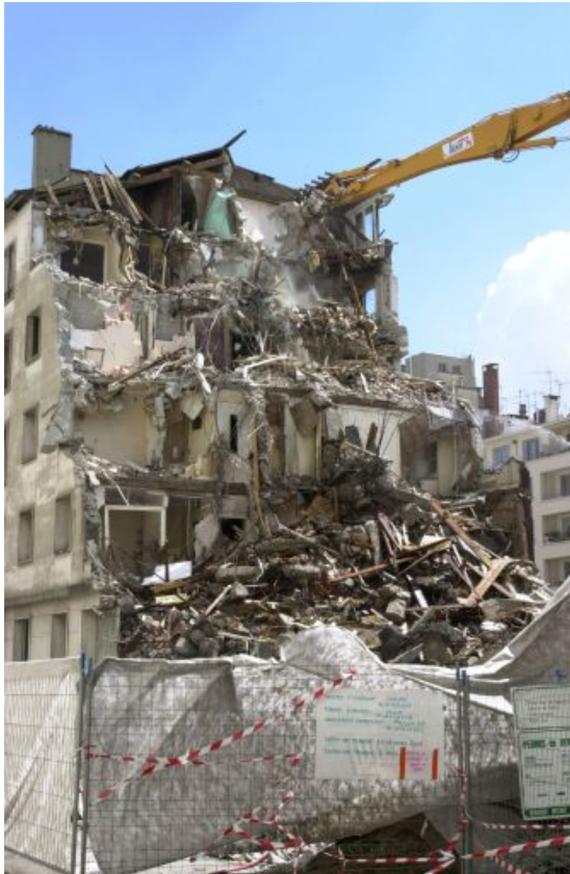
Détail de l'immeuble en cours de destruction
