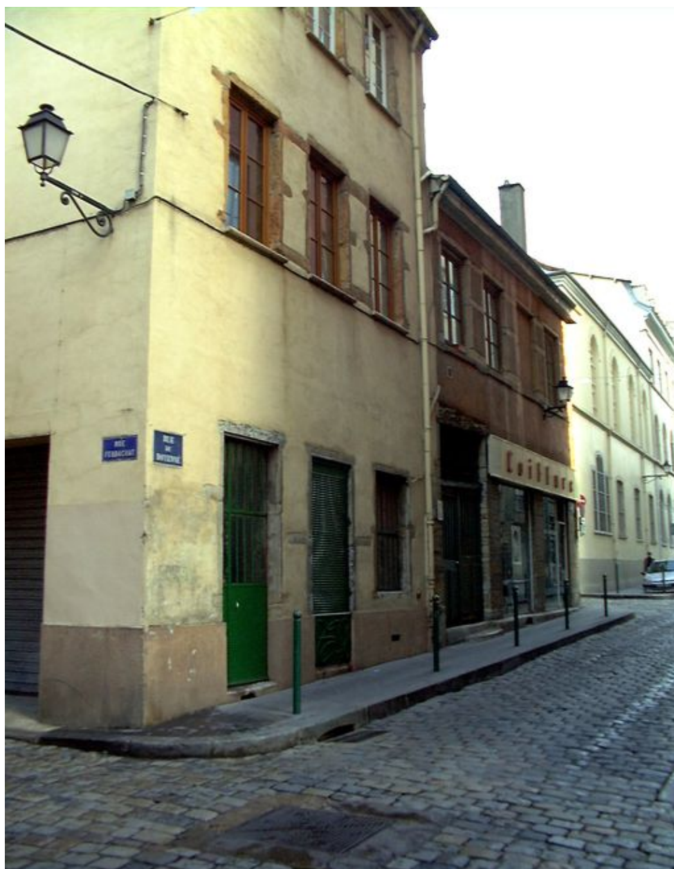
Elévation rue du Doyenné
