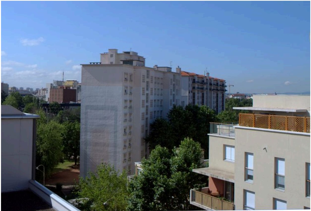
Elévation postérieure, partie supérieure, depuis le nord-ouest
