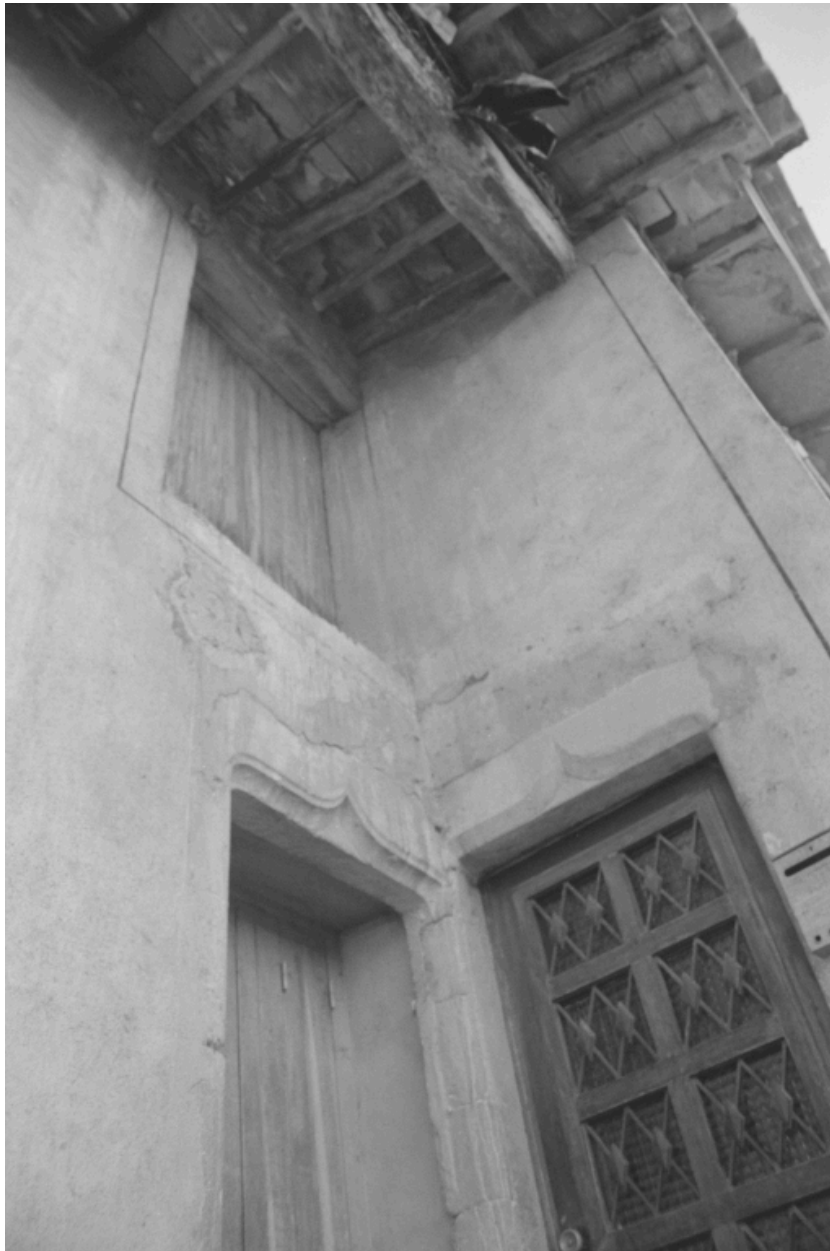
Elévation sur rue, détail des baies protégées par l'avant-toit.
