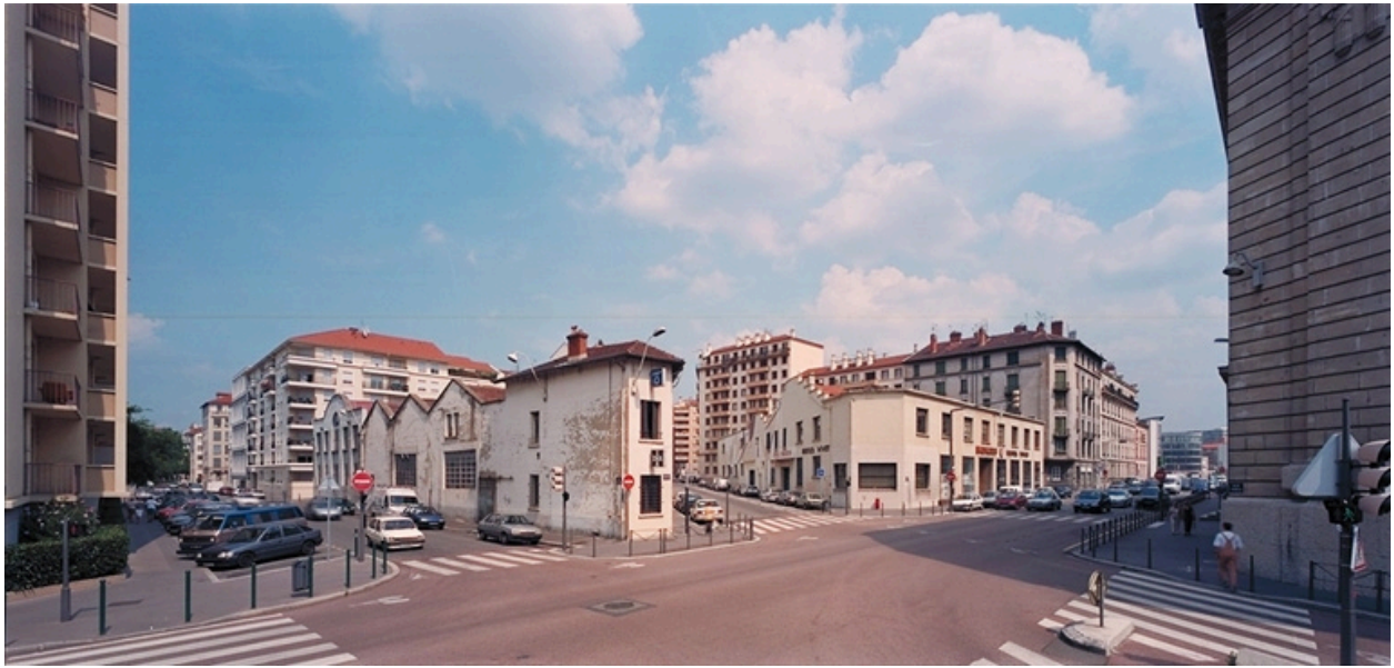
Vue générale des deux bâtiments
