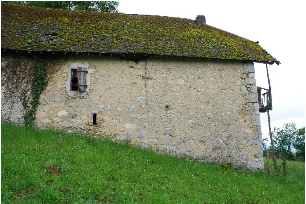
Vue partielle de la façade latérale arrière.
