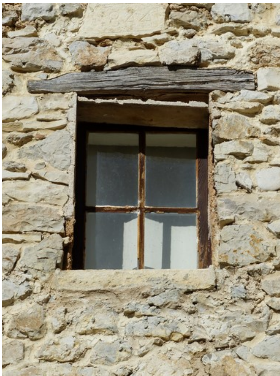
Pignon sud, troisième niveau. Fenêtre.
