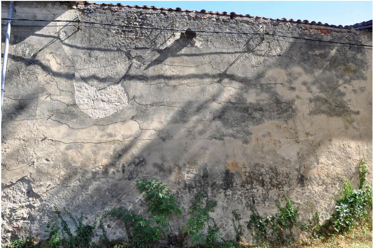
Mur de clôture enclavé entre la maison du jardinier et l'orangerie
