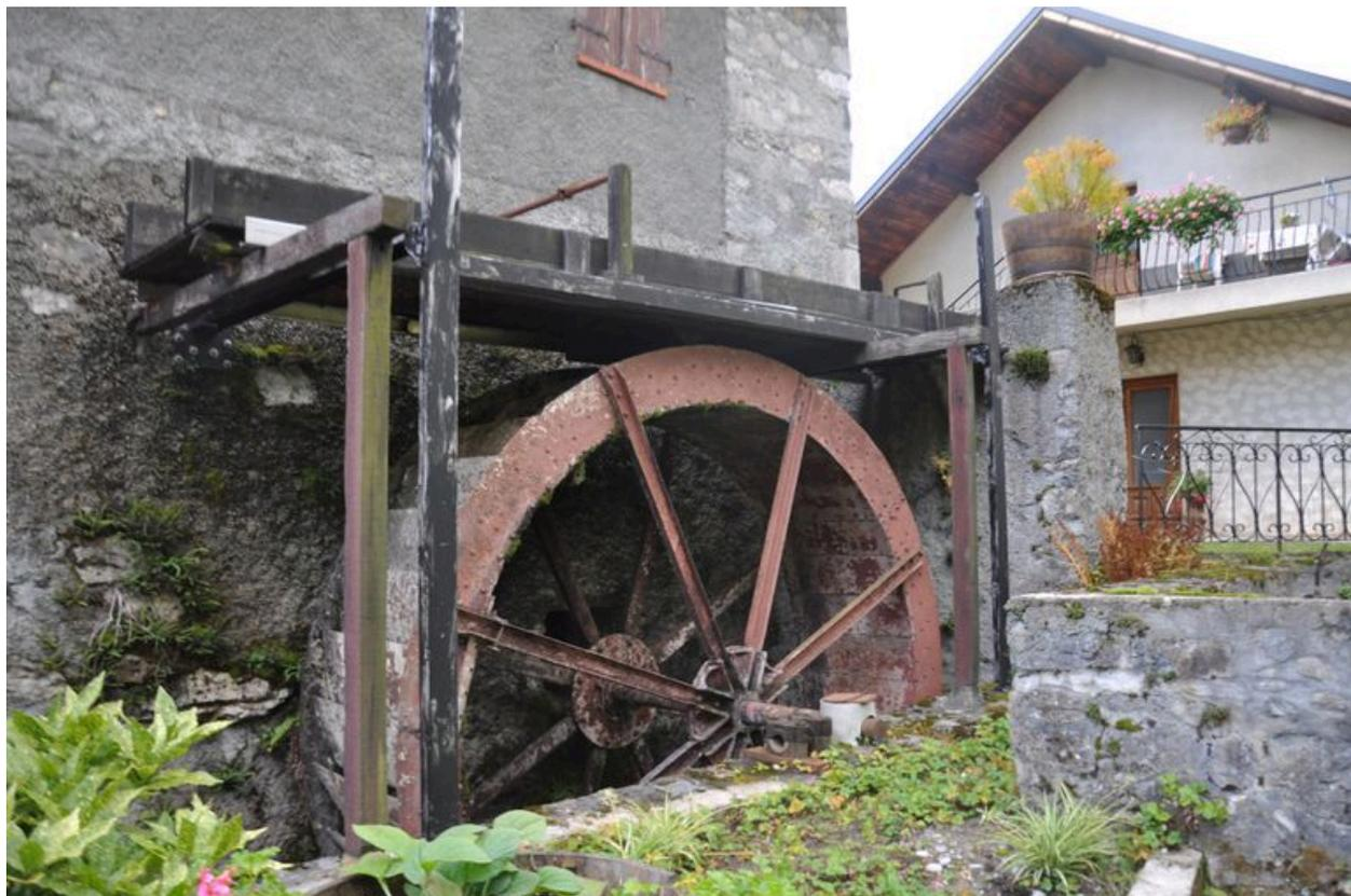
Détail de la roue à augets métallique du moulin
