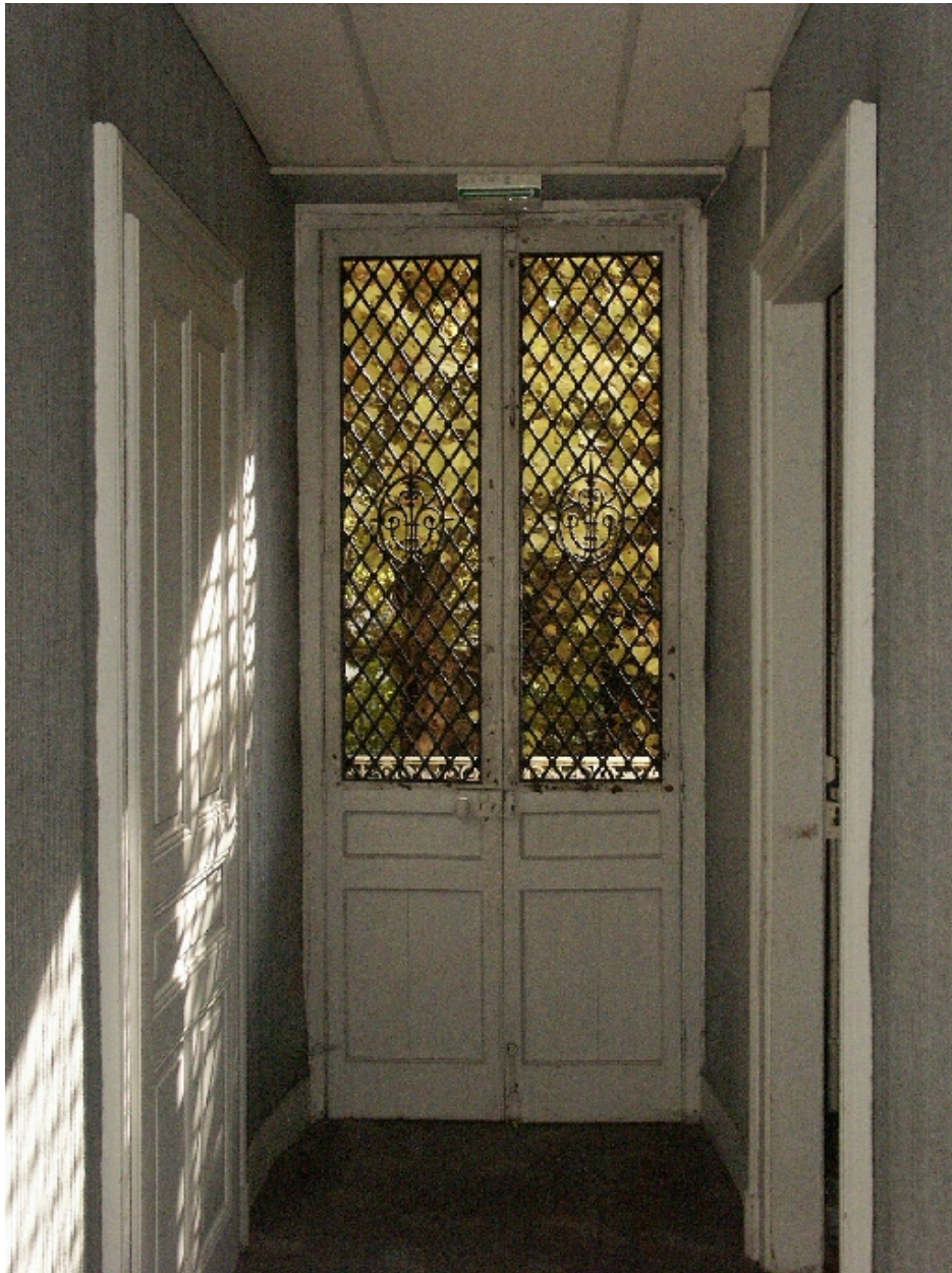
Porte du 1er étage sur balcon-galerie
