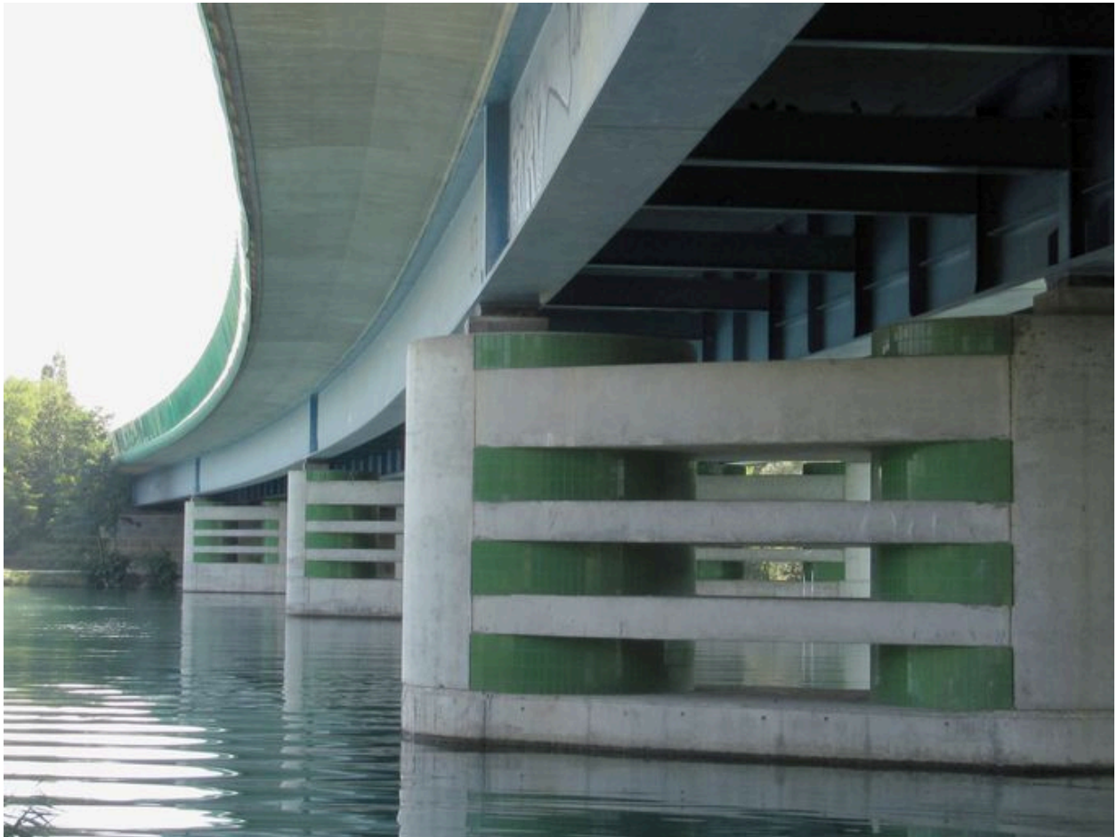
Vue partielle, de côté, piles et tablier, face amont (depuis la rive droite)
