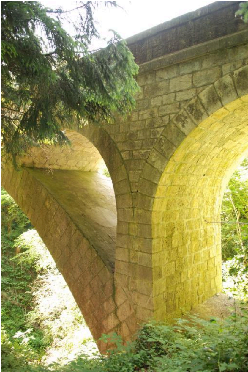
Détail de l'arche du pont actuel.
