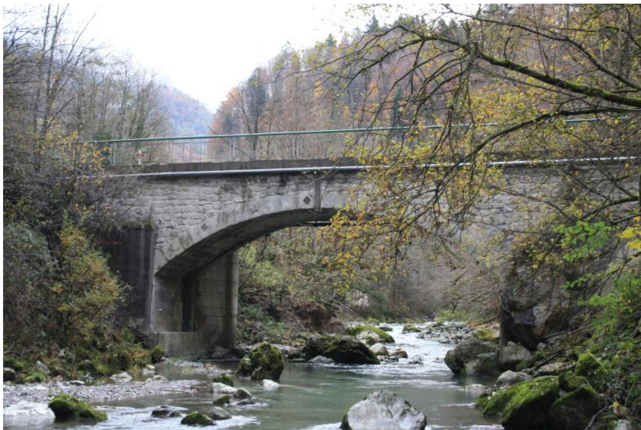
Pont de la Forclaz, face en aval
