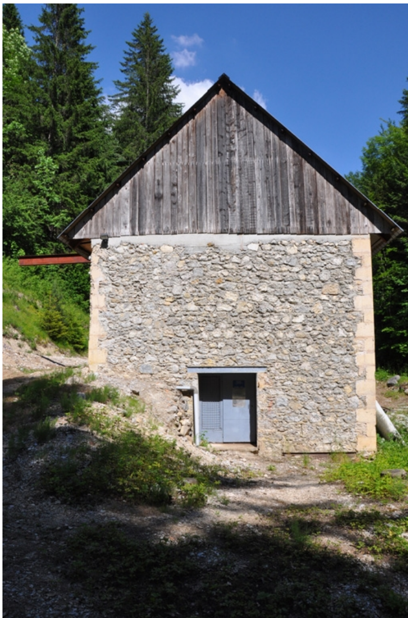
Centrale hydroélectrique, façade ouest
