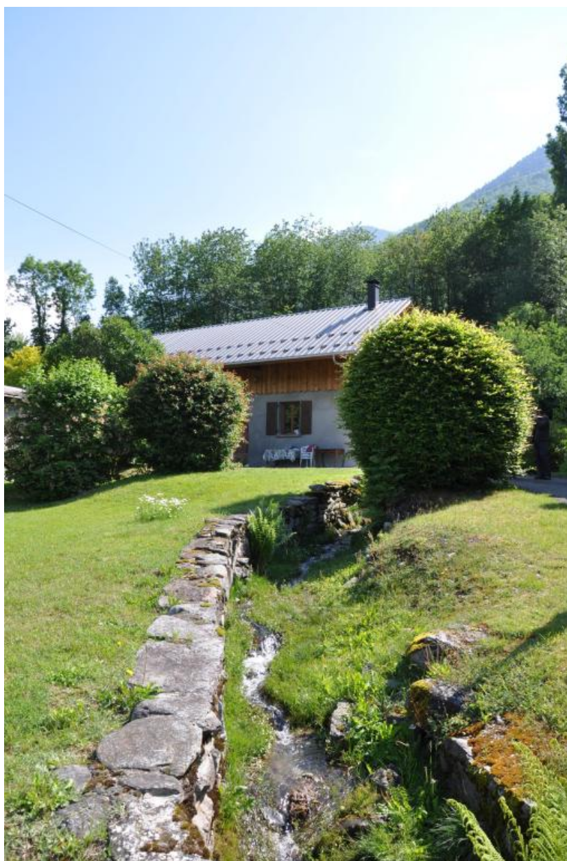
Vue aval du canal de Charrière chaude et du moulin.
