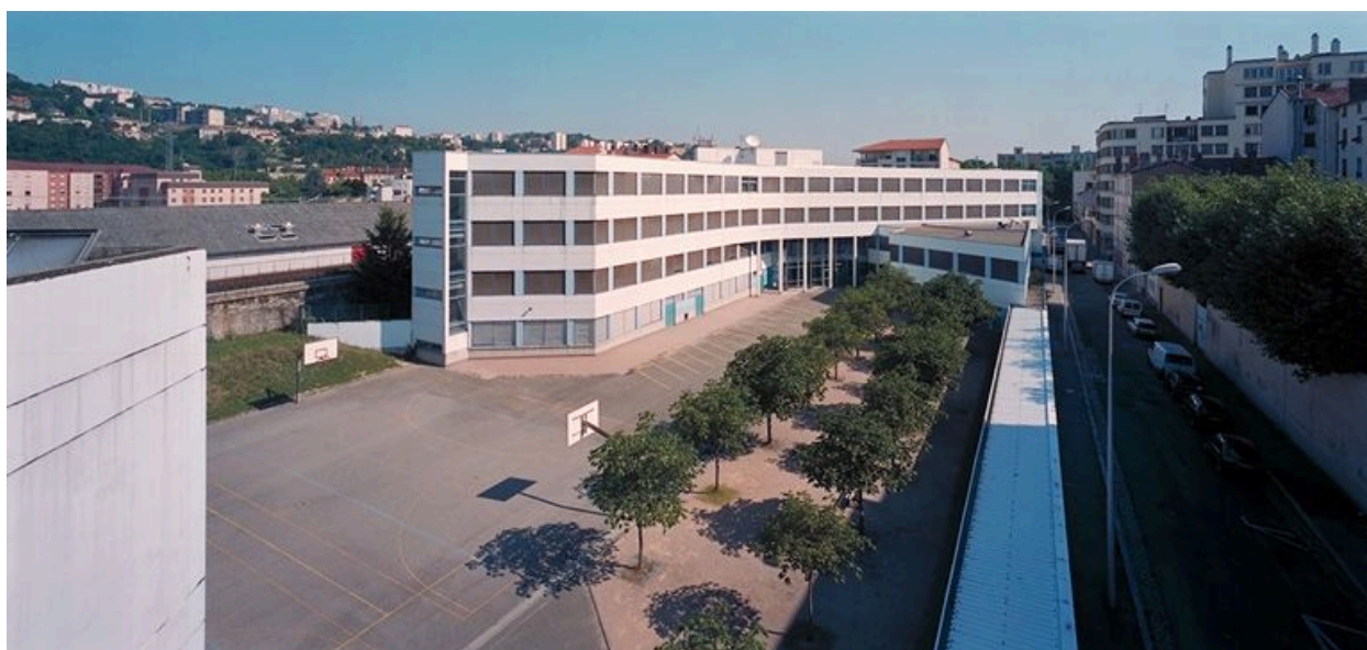
Corps de bâtiment principal (enseignement) depuis la terrasse des logements de fonction
