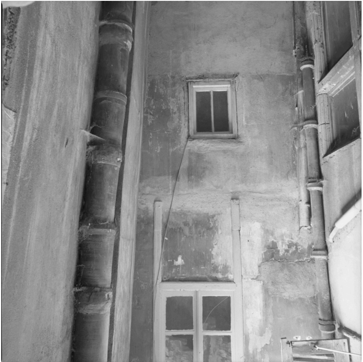
Conduite d'évacuation des anciennes latrines, en grès.
