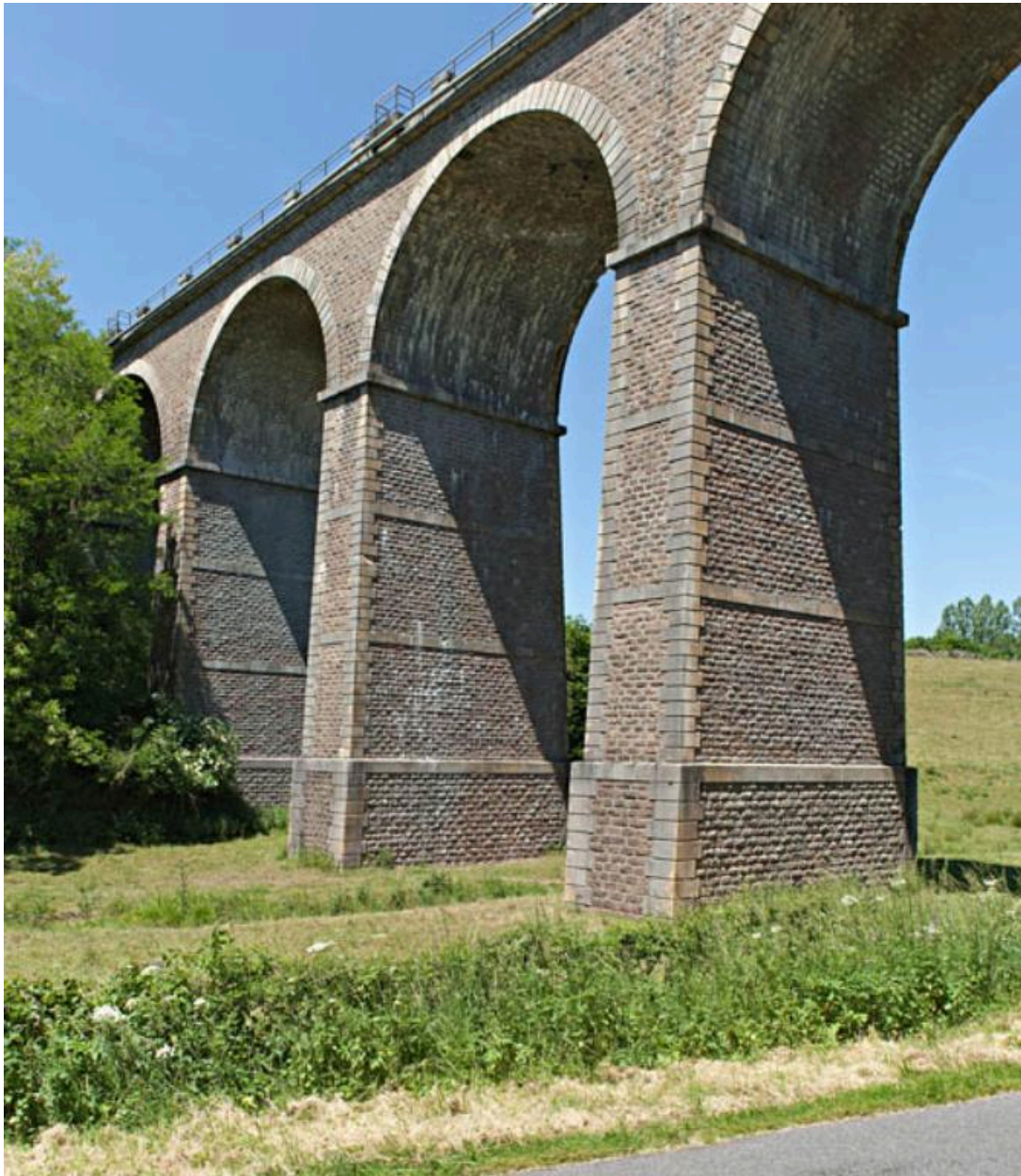
Vue partielle de trois quarts du viaduc de Montciant.
