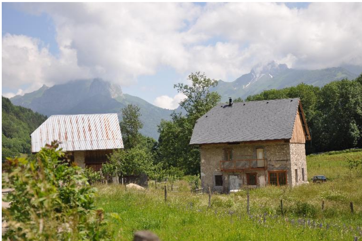
Vue générale du site.
