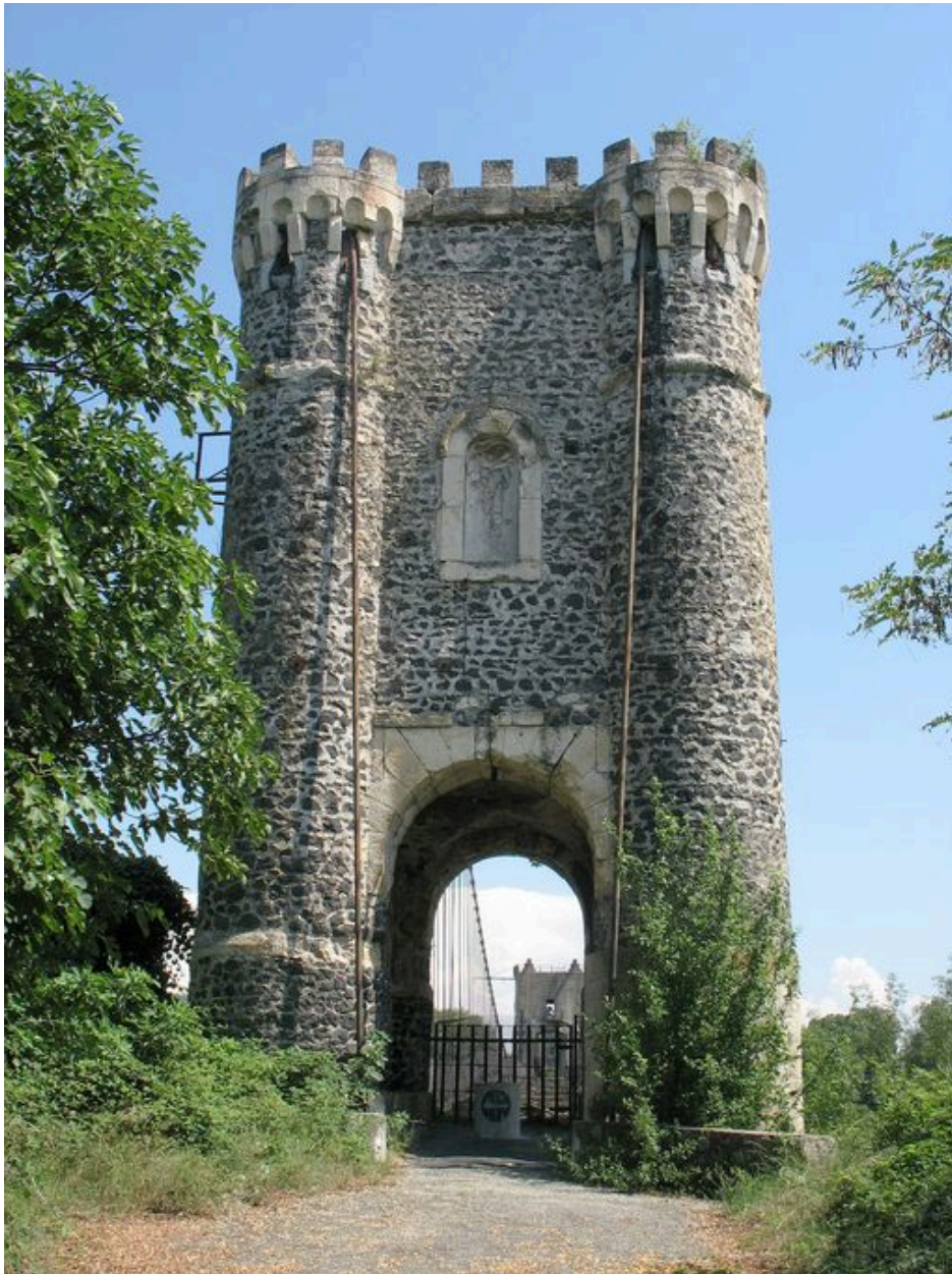
Tour formant tête de pont sur la rive droite, face nord-ouest : vue rapprochée
