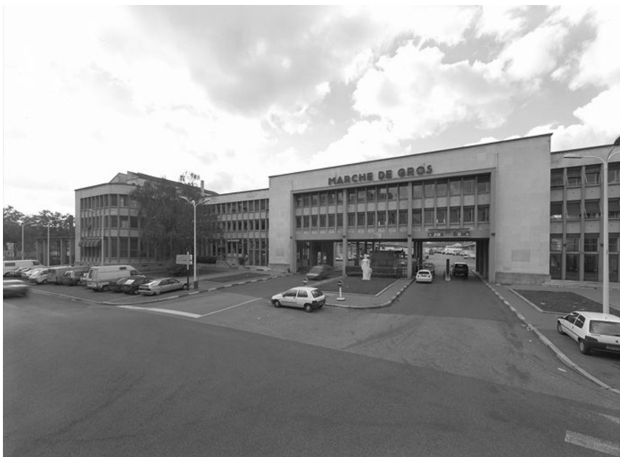
Elévation sur la rue Casimir-Perier : partie nord-est
