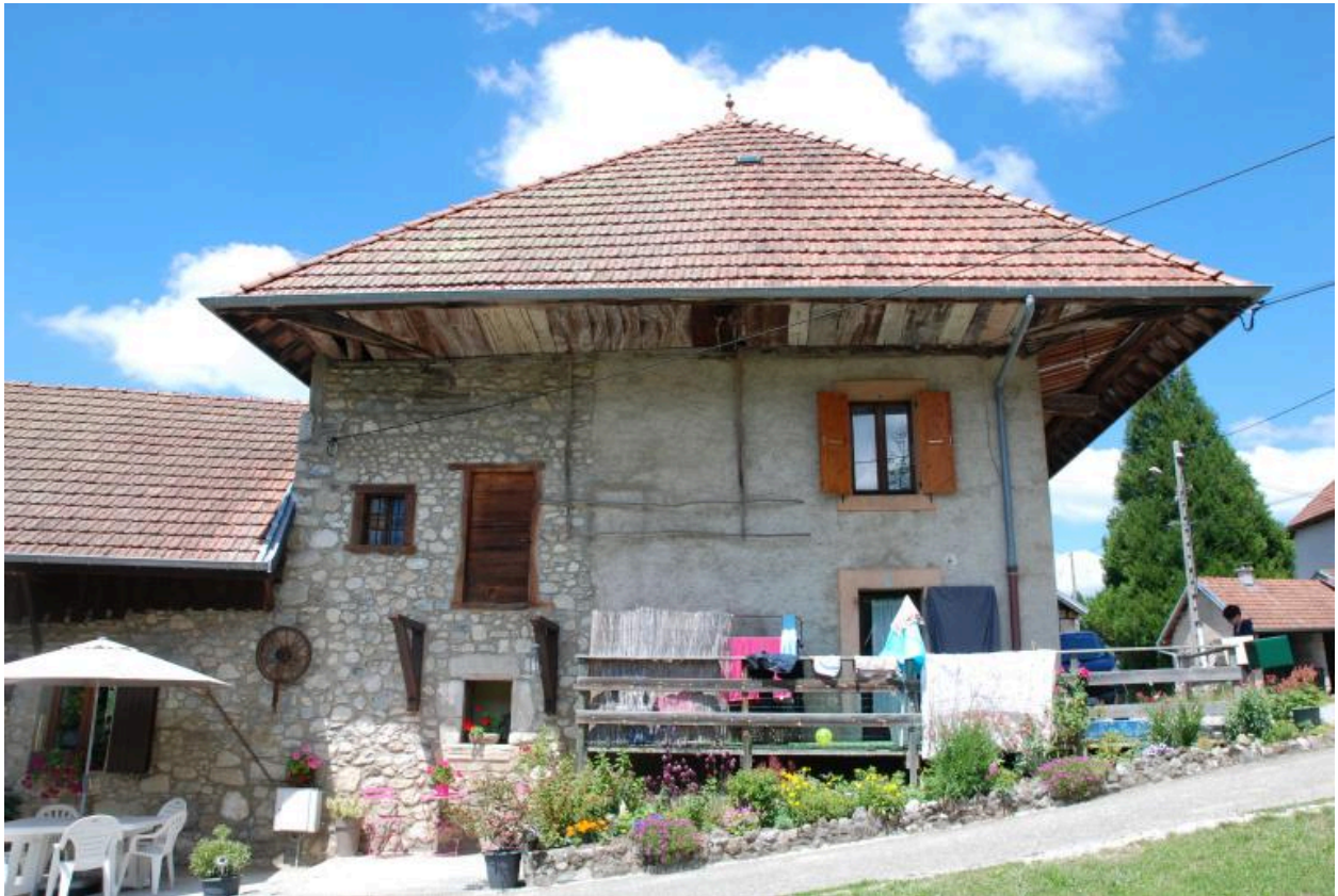
Vue de la ferme située à l'emplacement de la maison des Blanli, élévation sud.
