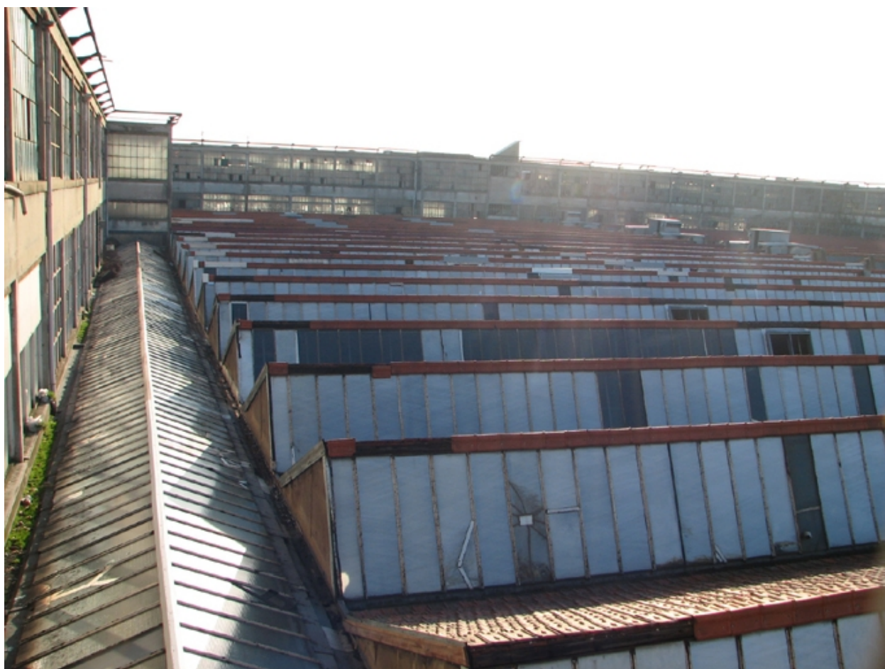
Vue nord de la toiture shed
