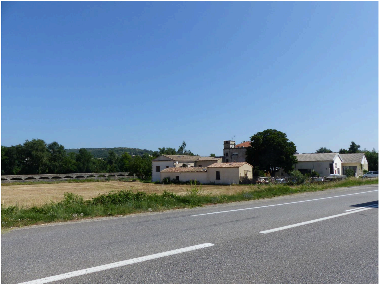
Moulinage de la Neuve et aqueduc à Chomérac vue d'ensemble
