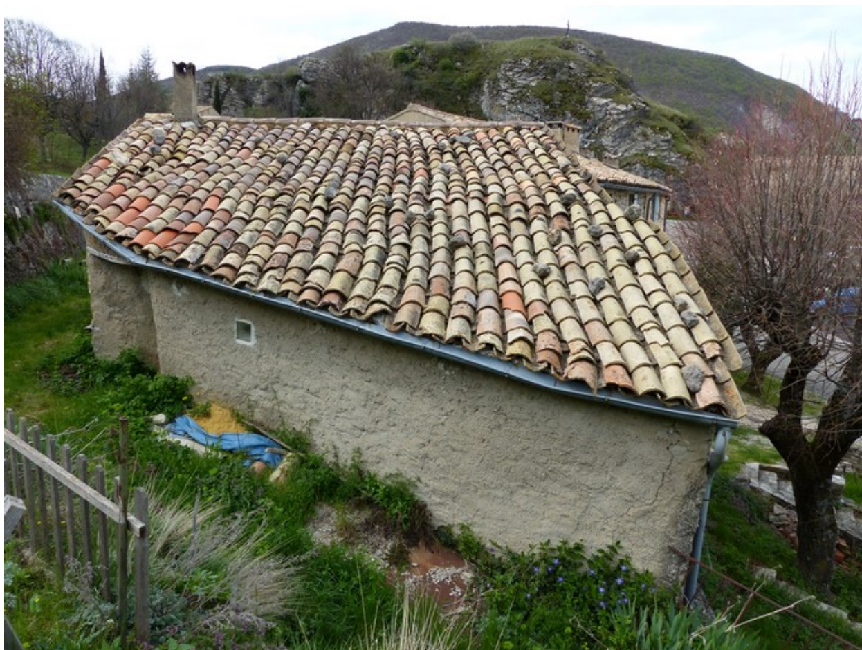
Vue d'ensemble prise du nord.
