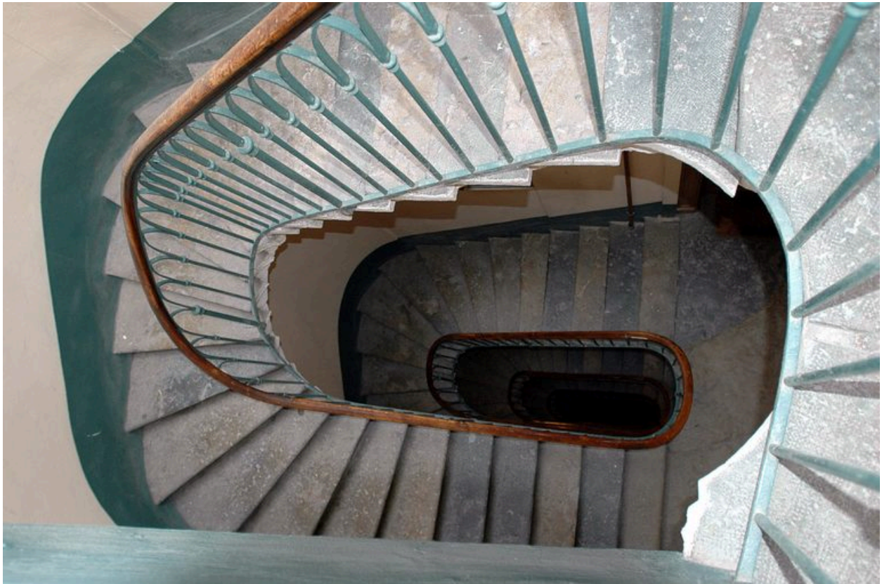
L'escalier en plongée
