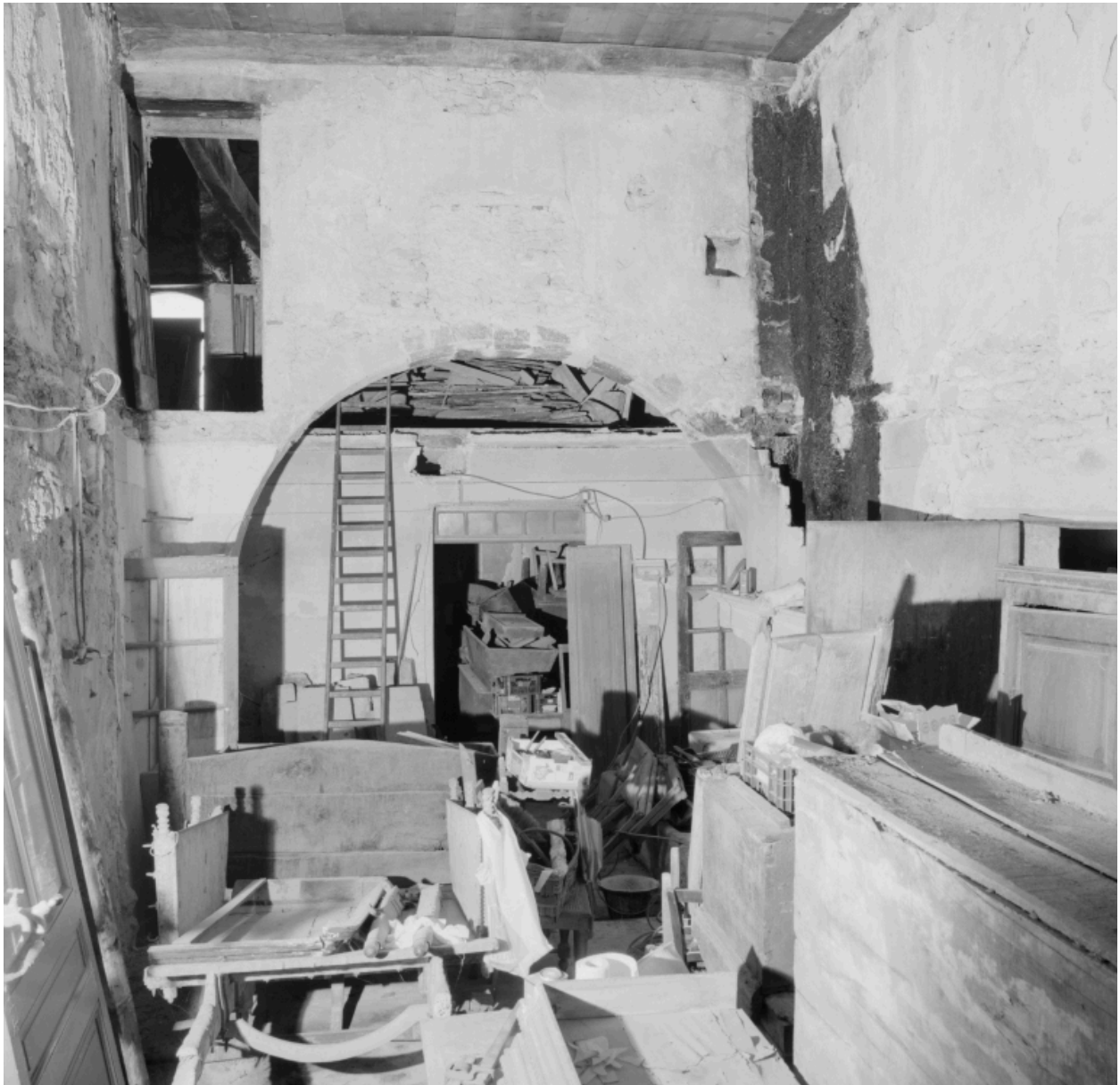
Corps nord, rez-de-chaussée, vue intérieure : arc de communication en plein cintre dans le mur de refend.
