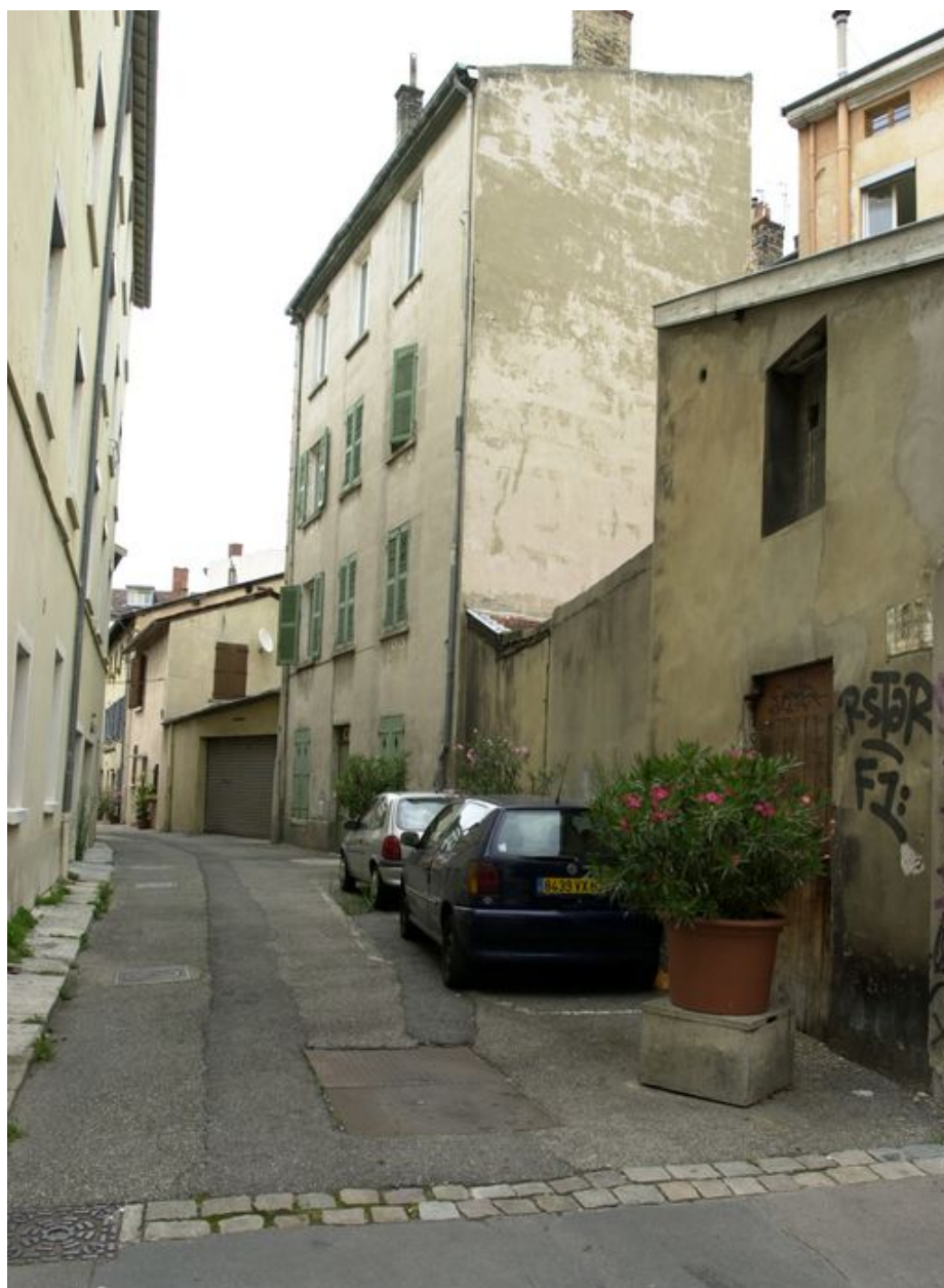
Vue générale depuis l'entrée de l'impasse au sud
