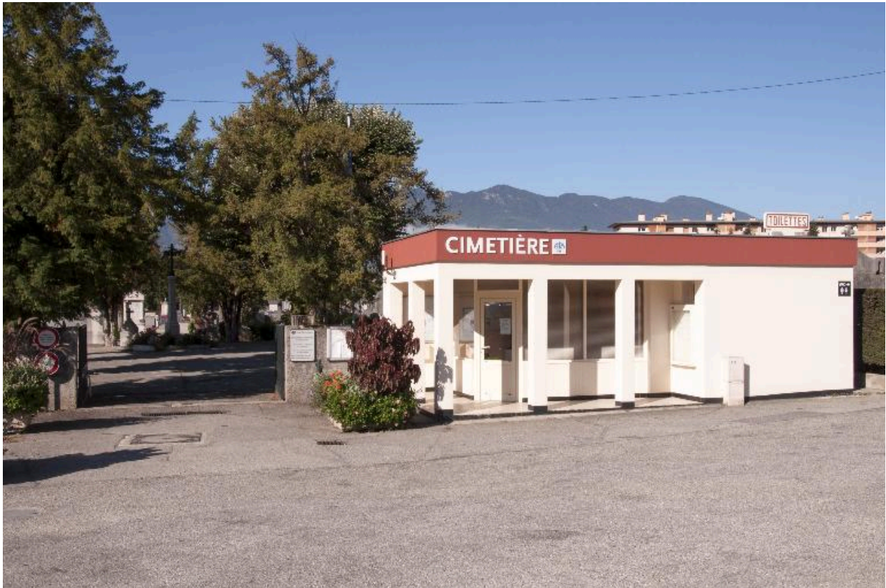
Bâtiment d'accueil à l'entrée principale
