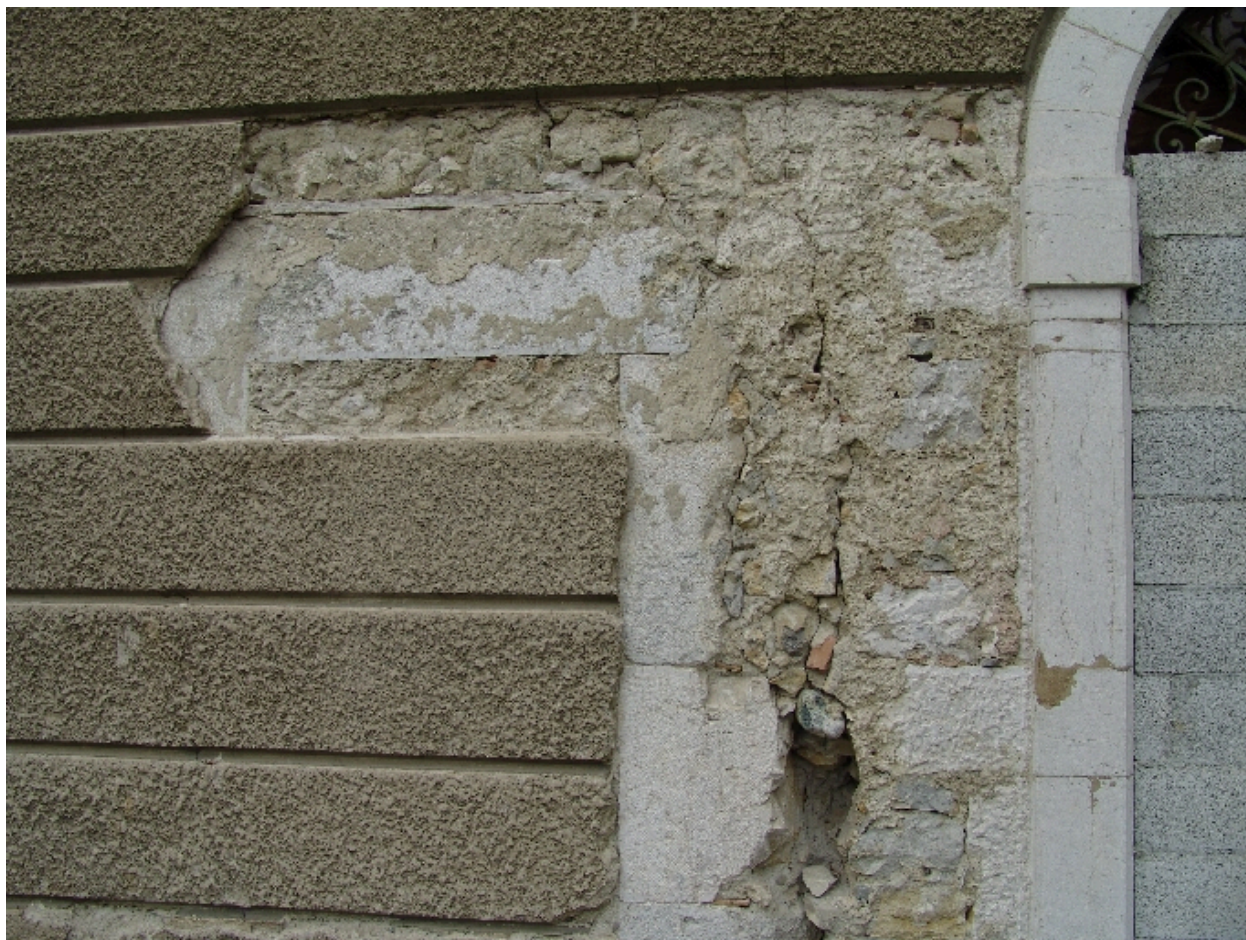
Détail de maçonnerie
