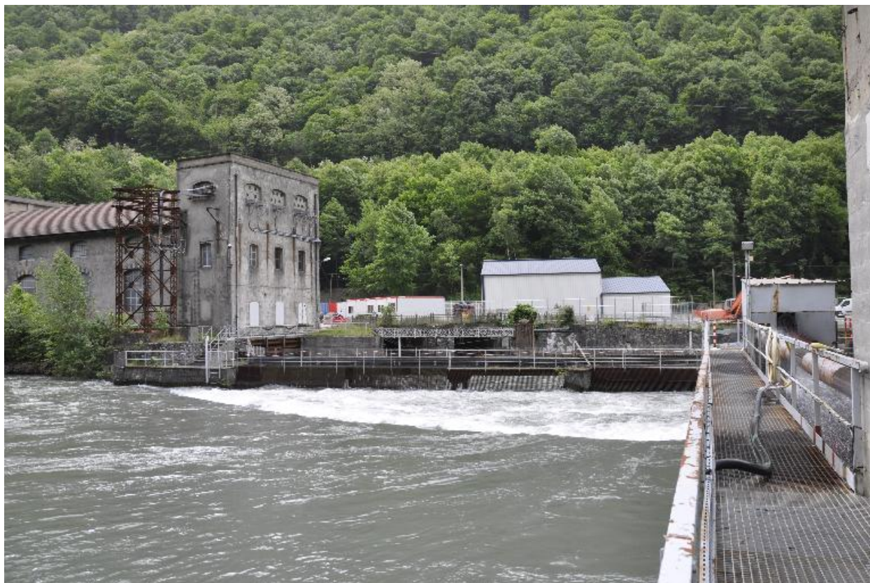
Vue du barrage et de la centrale
