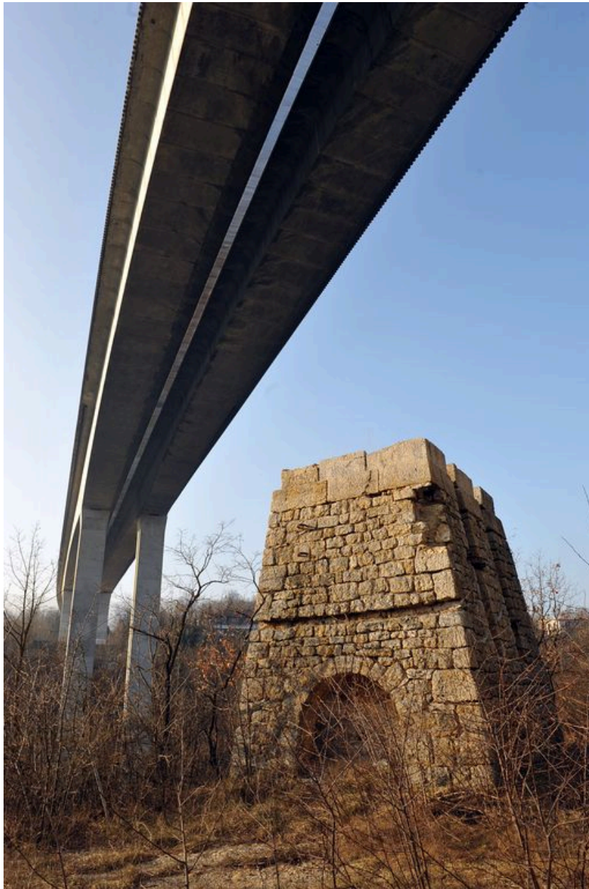
Vue partielle, dessous du tablier (depuis la rive droite)
