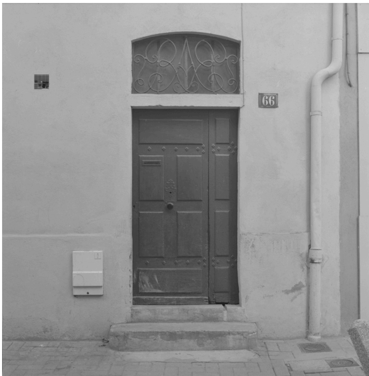
Porte d'entrée sur rue.
