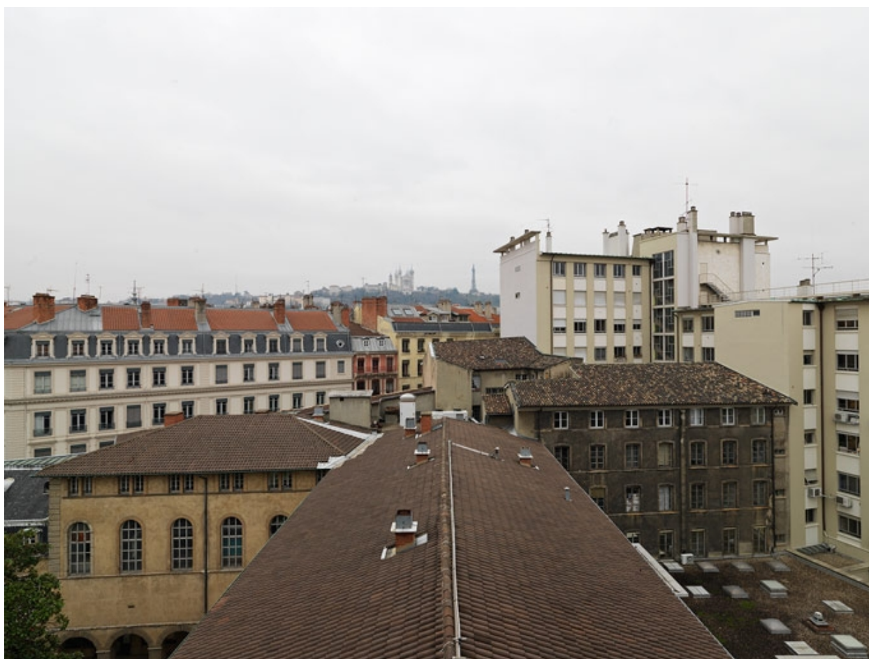
Bâtiment S. Les corps sud et nord, de part et d'autre du bâtiment Q, vus depuis le dôme des Quatre Rangs
